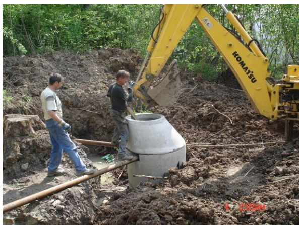
Obr. 5 Osadzovanie betónovej šachty
