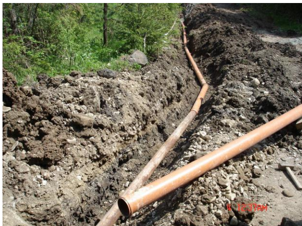
Obr.3 Výkopové práce – odvedenie vôd pomocou PVC rúry s priemerom 110 mm
