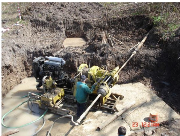
Obr. 1 Vŕtanie subhorizontálneho vrtu
