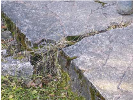
Obr.7: Posunutý chodník pri RD č.139
